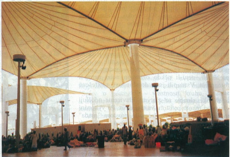
Otevřené čekárny na letišti v Džidě jsou chráněny obrovskými slunečníky. Pohled z vnitřku.
